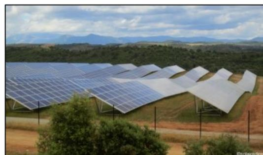
**La centrale photovoltaïque de Roulet-Saint-Estèphe sera d'une puissance crête installée de 7 MWc. Sa production estimée à 8 618 MWh/an.**
